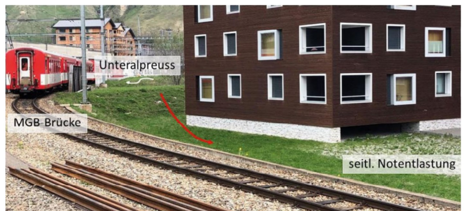
5: Sollte die Unteralpreuss bei der MGBahn-Brücke über den Damm schwappen, so kann sie seitlich durch die bauliche Notentlastung unter dem Gebäude geführt werden ohne grösseren Schaden anzurichten Quelle: MGBahn
