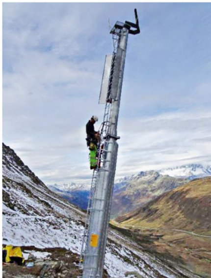
6: Montage eines Lawinensprengmastes. Die Trommel mit den Sprengladungen erfolgt per Helikopter direkt auf den Masten Quelle: geoformer igp AG
